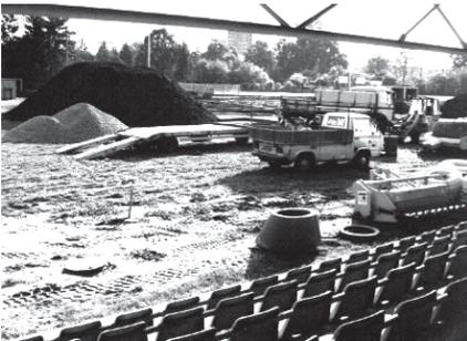
*rechts: Anlieferung einer Zisterne als zusätzlicher unterirdischer Wasserspeicher*
